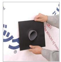
②ハイパットの丸穴 を押し広げ、パイプ に装着します。その 際ハイパットの開口 部が裂けない様に注 意して取り付けます。
