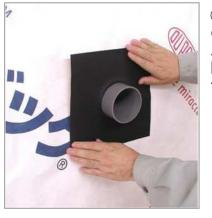
③ハイパットの裏面の粘着層をパイプに圧着して、更に透湿防水シートに密着させます。
