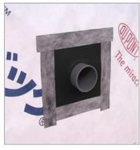
④ブチル系防水テープでハイパットの下辺、左右、上辺の順に透湿防水シートに密着させます。
