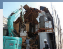
実際の解体現場から採取
