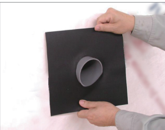
②ハイパット®の丸穴を押し広げ、パイプに装着する。その際にハイパット®の開口部が裂けない様に注意して取り付ける。
