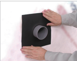
③ハイパット®の裏面の粘着層をパイプと透湿防水シートに圧着、密着させる。
